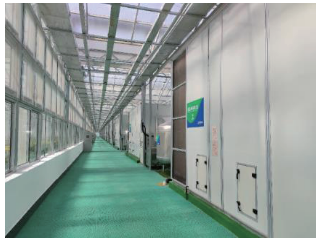
图 2 基于正压通风的温室环境综合调控系统
